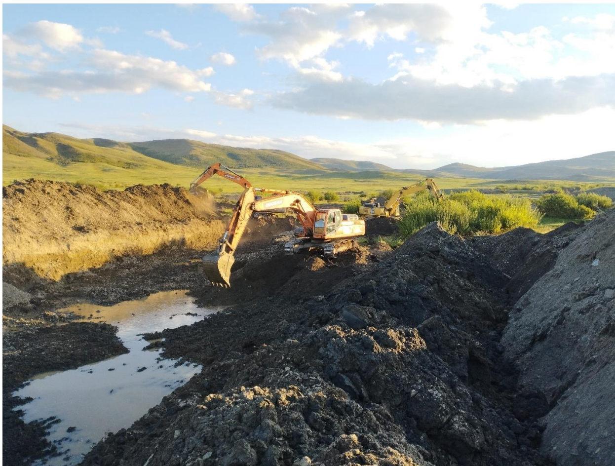
Рисунок 3. Вскрышные работы на участке Сарыбулак
